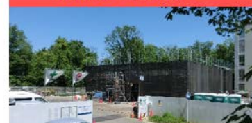
建設工事の様子
